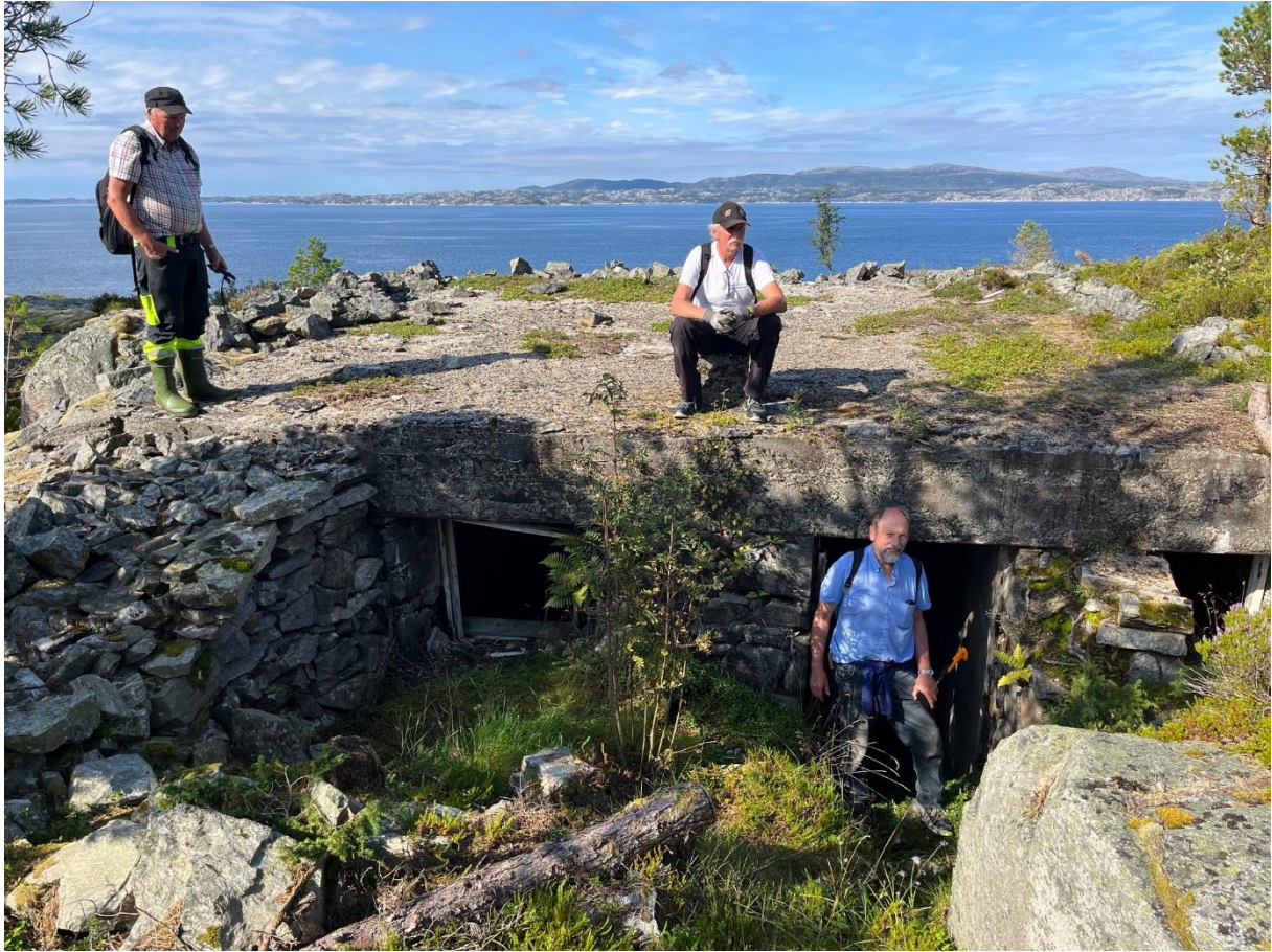
Figur 75 Oversikt over taket og inngangspartiet på bunkeren. Hitra i bakgrunnen.
