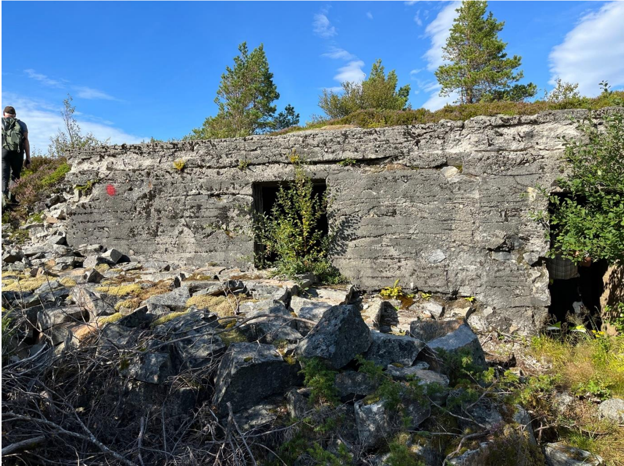
Figur 86 Oppgangen til kanonstillingen fra mannskapsbunkeren.
