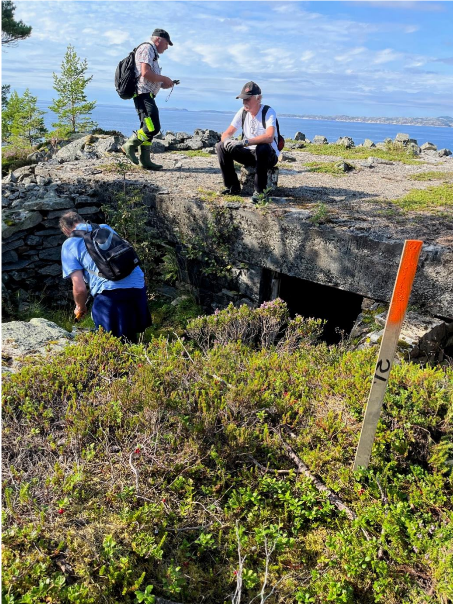
Figur 74 Ryddearbeid rundt bunkeren.
