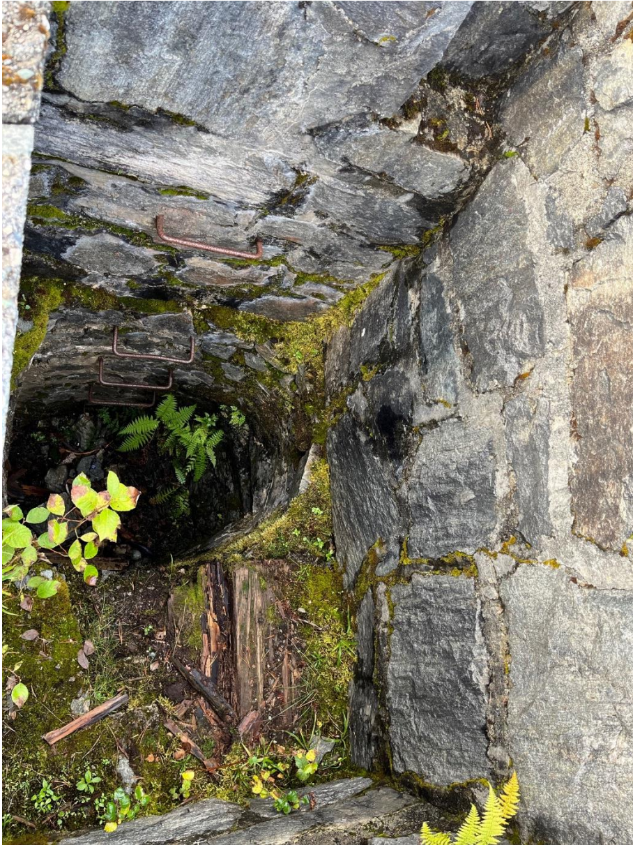
Figur 99 Jernbøyer til å ta seg ned i bunkeren fra utsiktsplassen.
