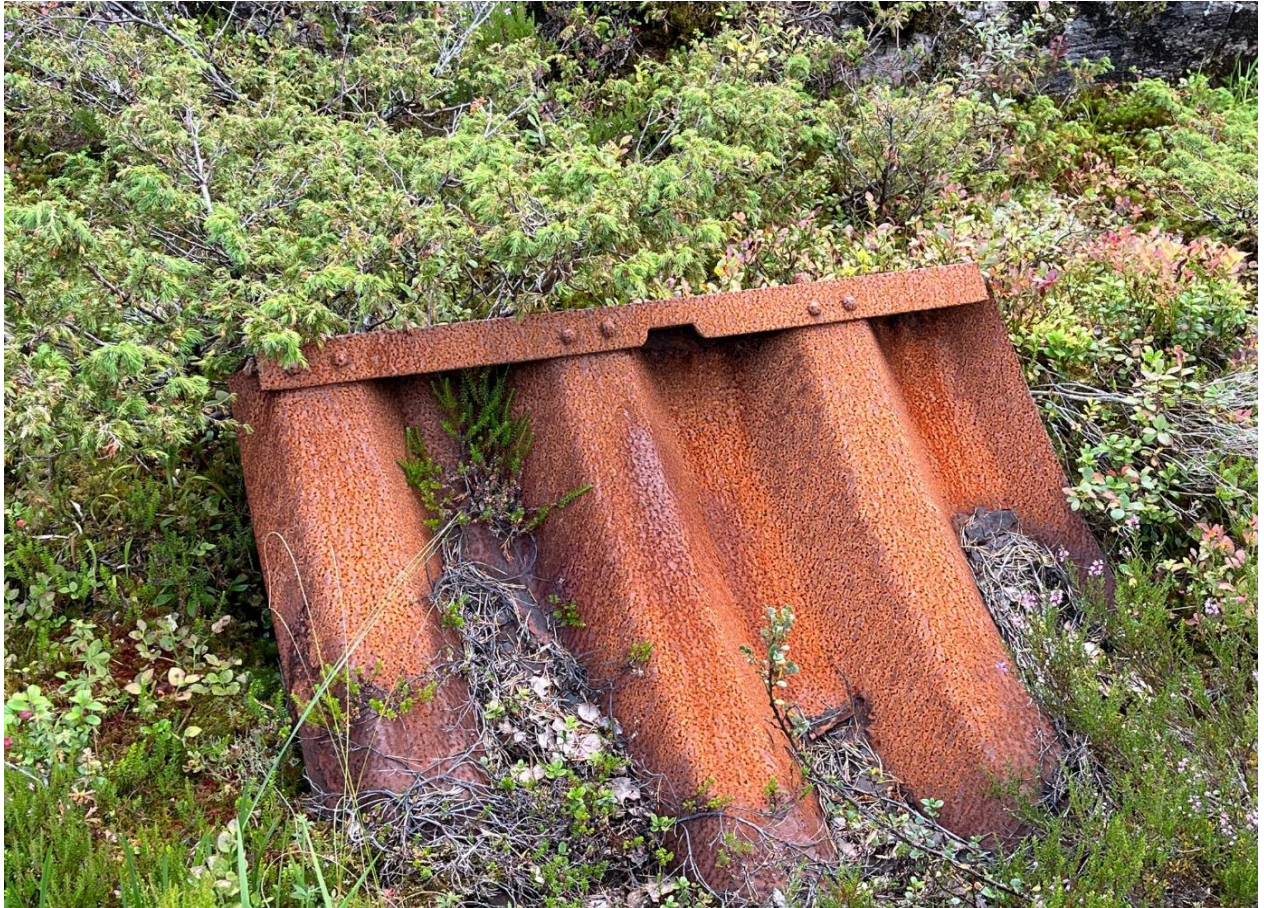
Figur 41 Rester av solide takplater, som vi tror kan stamme fra aggregathuset.
