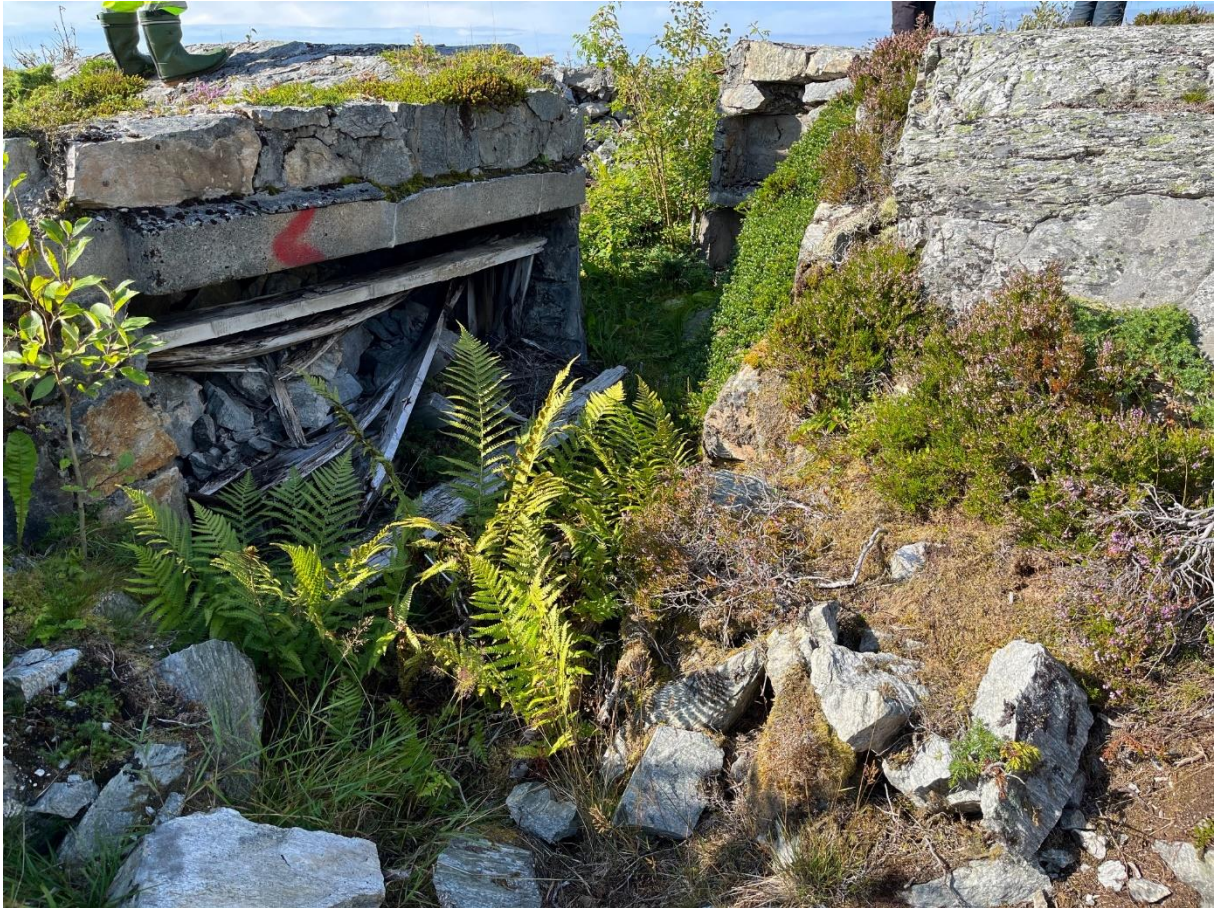
Figur 83 Både inngangen til stillingen og selve ringen er noe gjenvokst.
