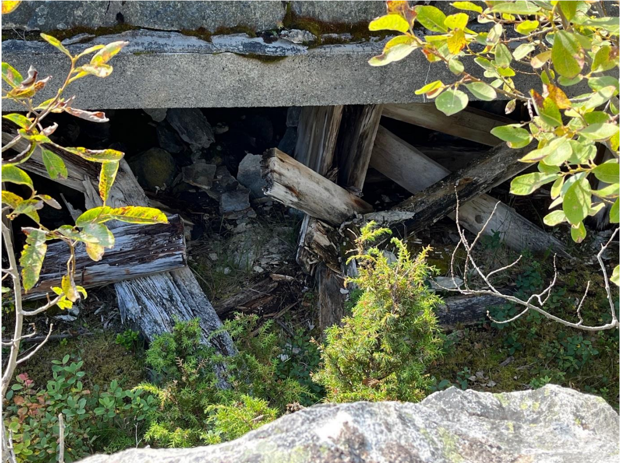
Figur 61 Oppbevaringsrom for ammunisjon ble også ryddet.
