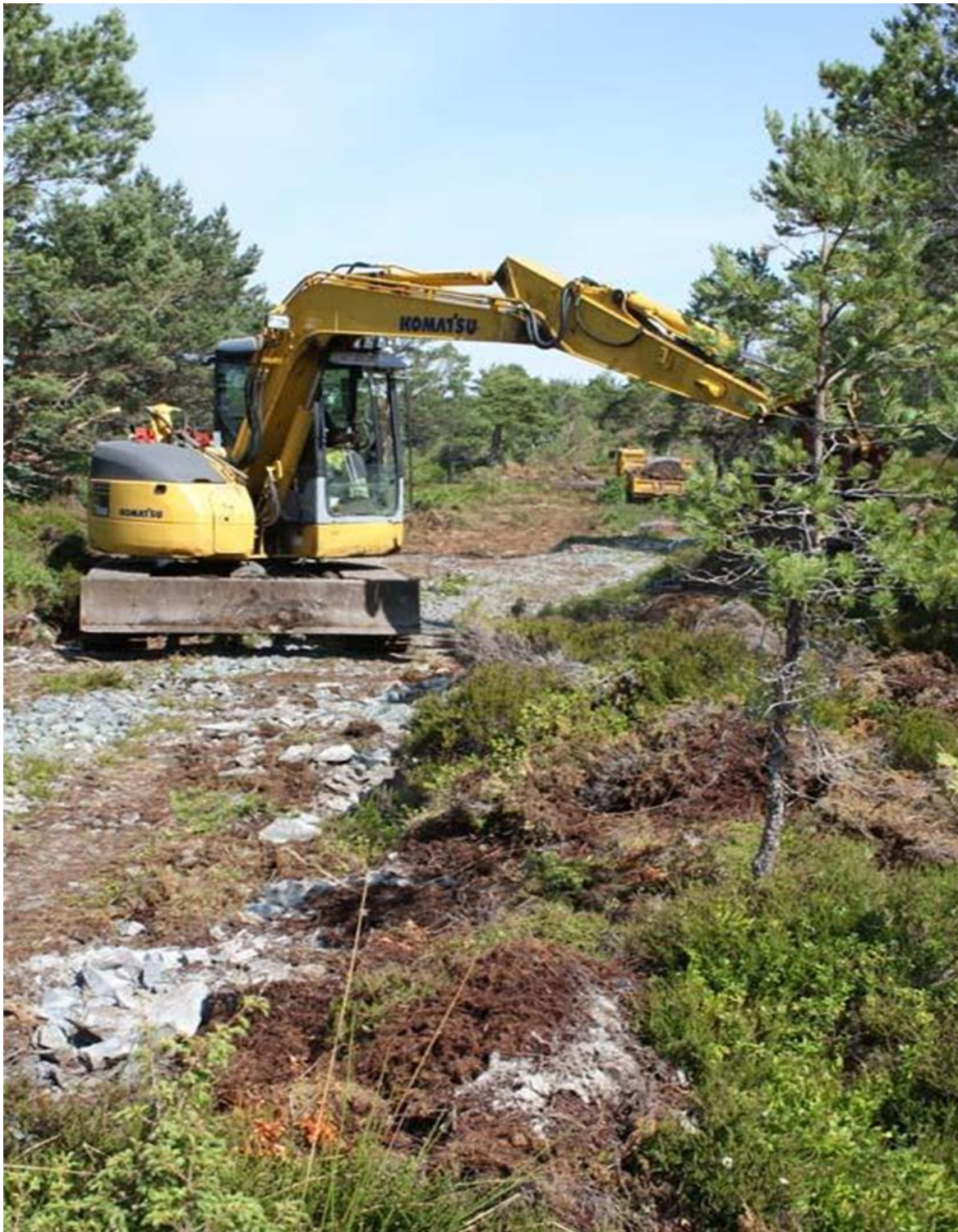
Figur 4 Jan Melland bygger vei
