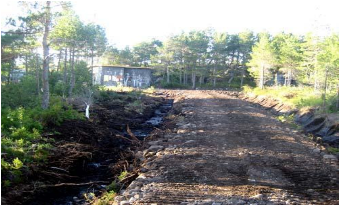
Figur 6 Siste del av veien fram til kanon 2 og 4 er i ferd med å ferdigstilles. Vi har bygd 500 meter vei!
