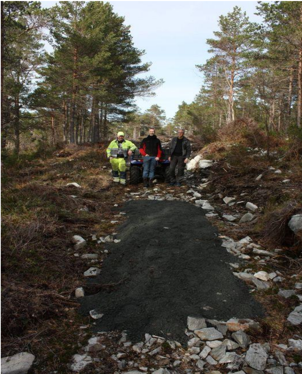
Figur 8 Prosjekt Østbatteri, den første delen av en 800 meter lang vei/sti
