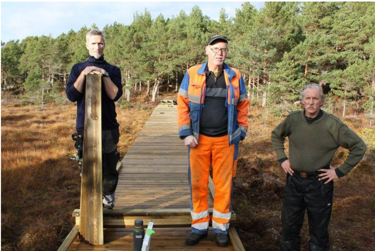
Figur 7 Det bygges bro over myra ved Kruttjønna, 2014
